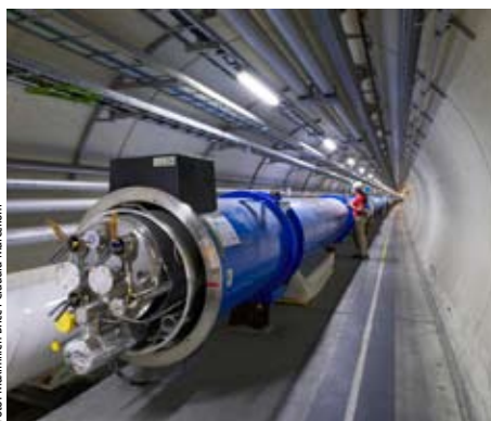
Montaż segmentów akceleratora LHC w tunelu na głębokości 100 m pod ziemią (ATLAS Experiment © 2013 CERN)
